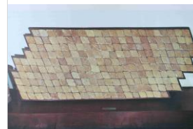
01567 PAVIMENTO LUGO DE LLANERA, LUGO DE LLANERA, LLANERA
